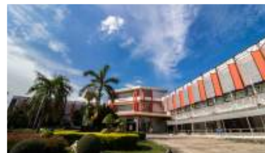
ก่อสร้างอาคารเรียนรวมหลังที่ 2 Construction of the Second Common Classroom Building.
